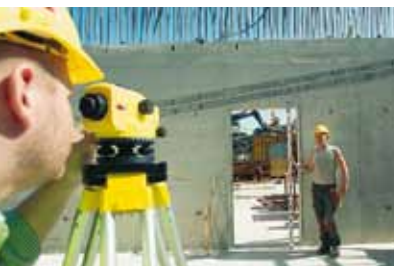
Hoch- und Tiefbau
